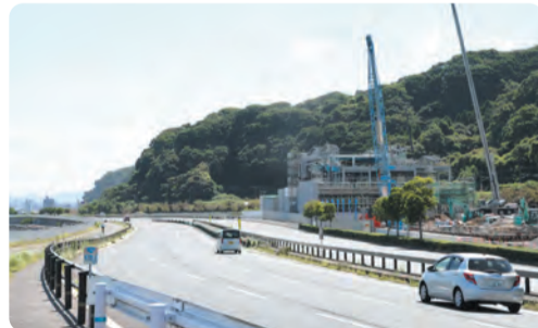
建設が進む道の駅のうらら
